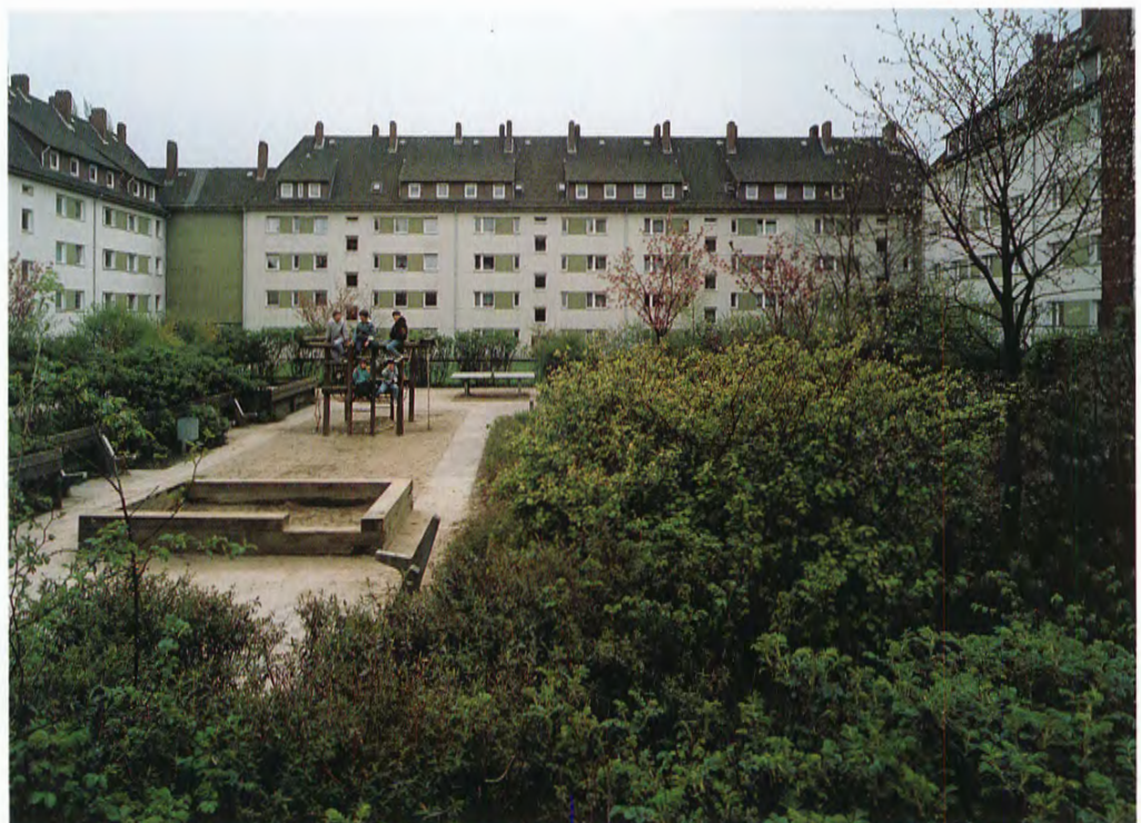
Hastedtstraße 22a/b, 22 – 28 Kroosweg 38 Göschelstraße 13/15 Baujahr 1951 Architekten: Karl Trahn u. Gustav Burmeister
