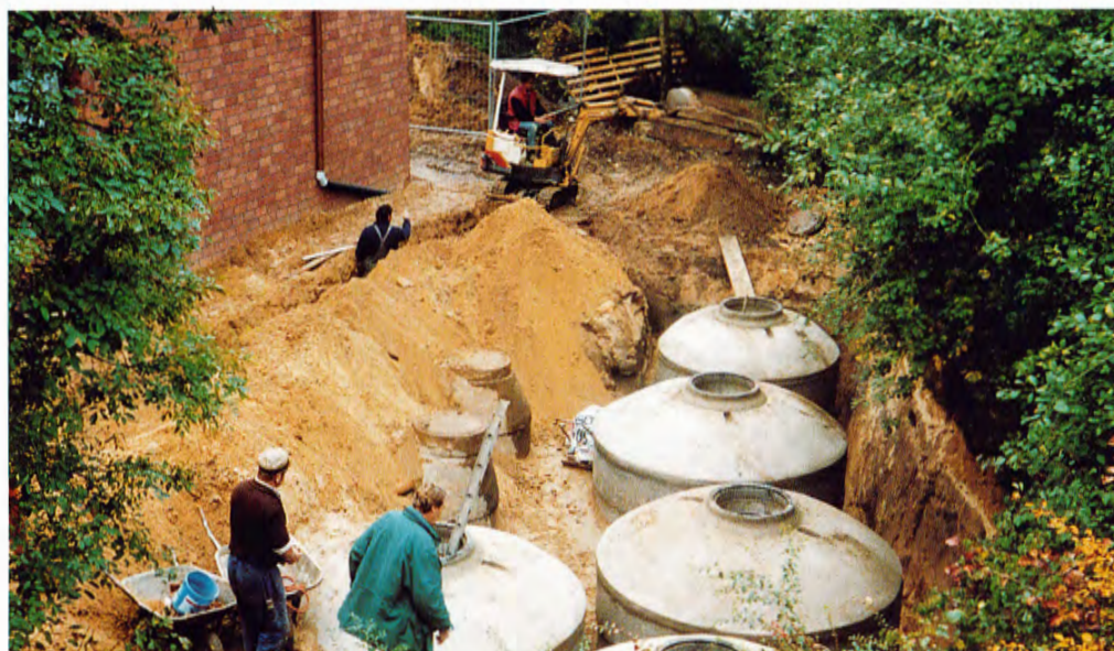
Regenwassernutzungs- anlage in der Beeren- höhe Einbau der Auffangbe- hälter für 44 Wohnun- gen – Brauchwasser für die WC-Spülung –
